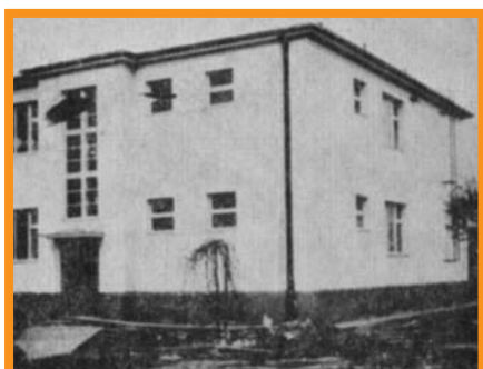
Obr. 2 Budova ústavu mesta Bratislavy pre skúmanie potravín živočíšneho pôvodu (1936)
